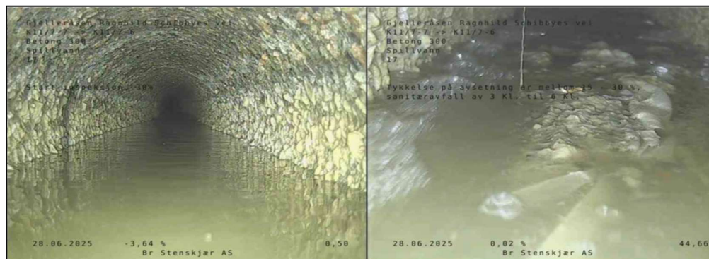
Figur 10: Strekk K11/ 7-7-> K11/ 7-6. Manglende tilslagsmateriale (venstre), avsetning med sanitæravfall (høyre).
