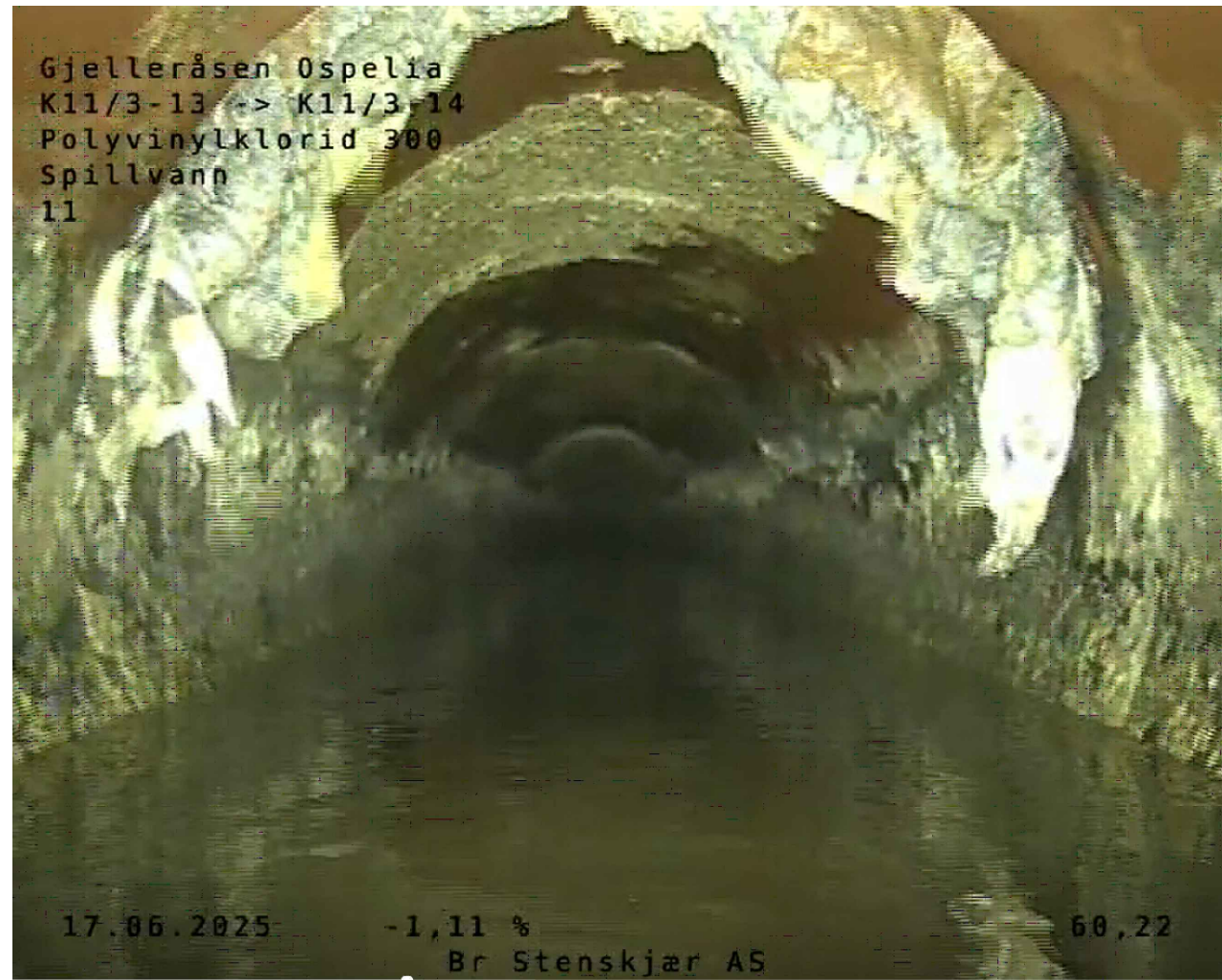
14.2 Avleiring av fett i røret , redusert tverrsnitt, ca 1274,22m
