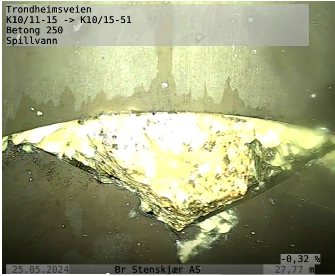
2.2 Rørvegen mangler 2, ca 43,38m
