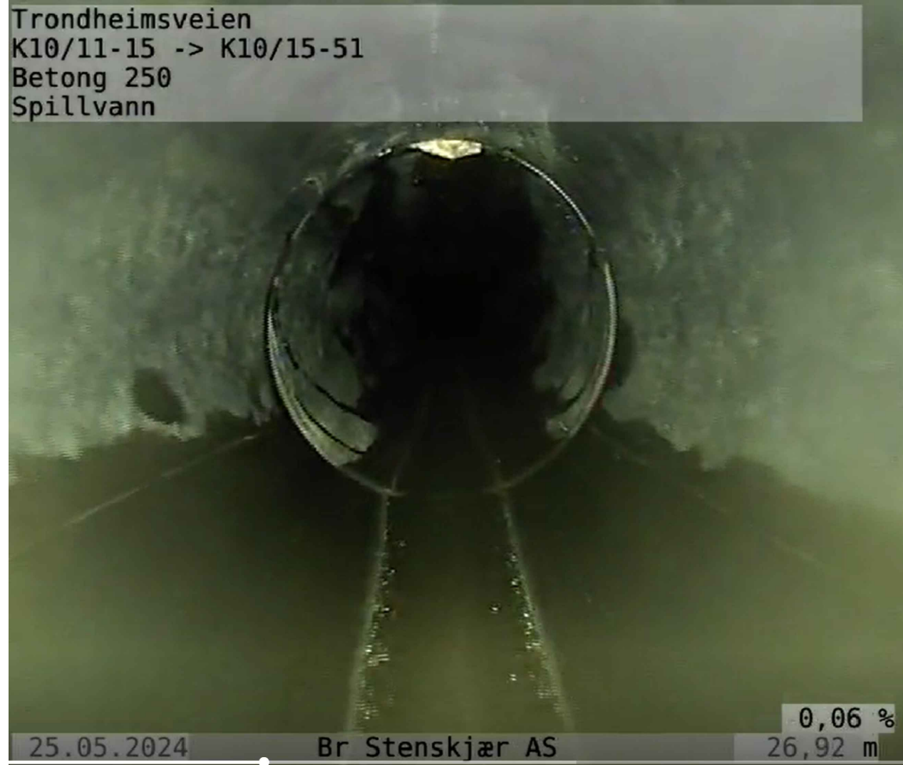
2.1 Rørveggen mangler 1, ca 42,76m
