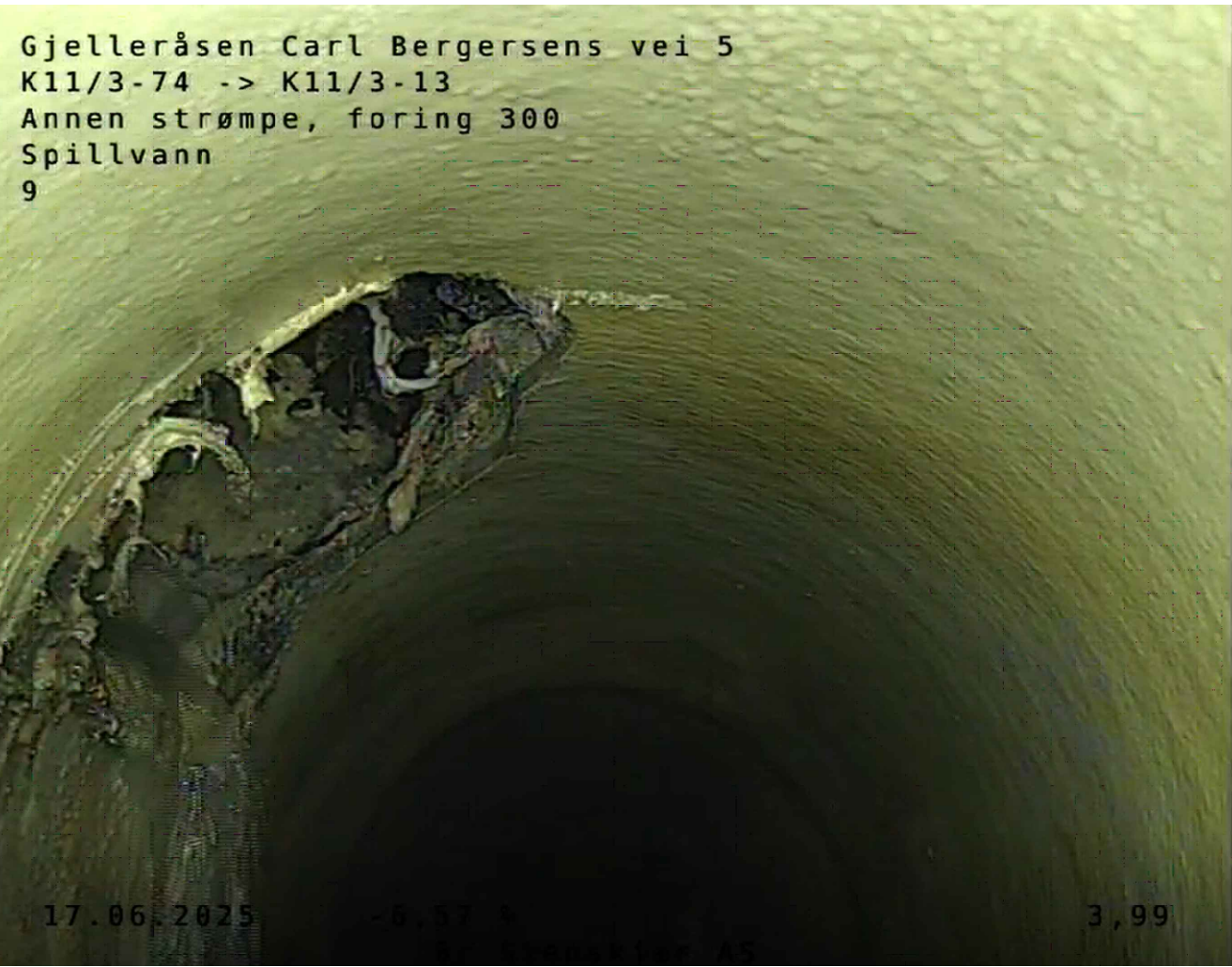
13.1 Tilkobling kum med grenrør, ca 1074,50m
