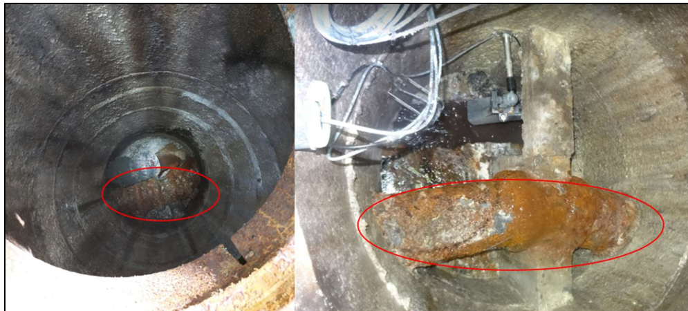
Figur 11: Vannledning lagt gjennom SP kummene K11/ 7- 7 og K11/ 7- 8.
