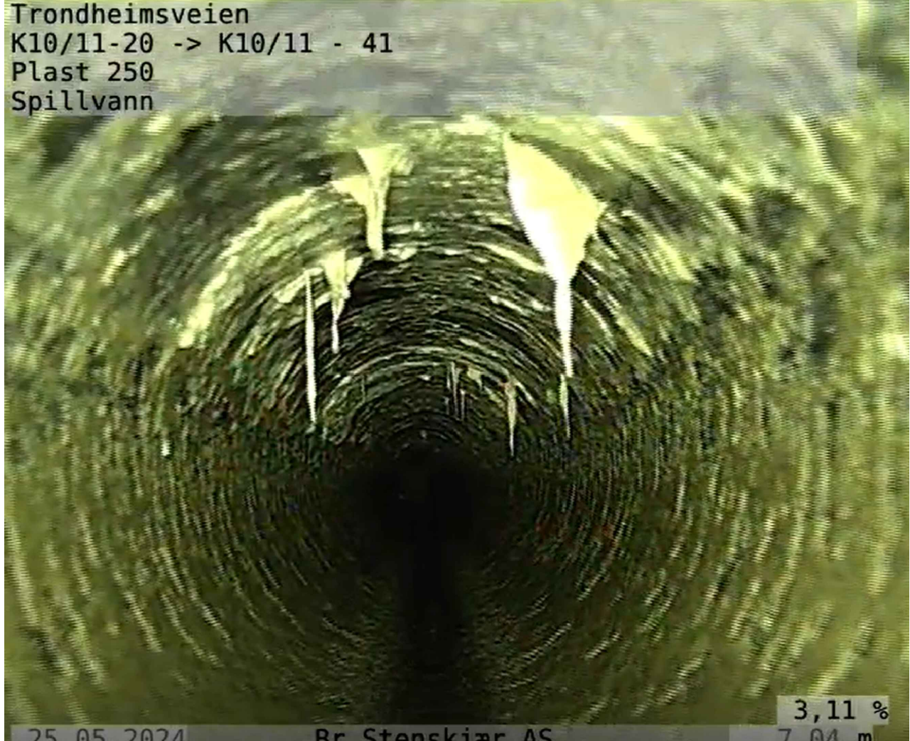
1.3 Tykk biofilm i hele røret og store klumper med avleiring i innløpskummen for pumpeledningene, ca 8,57m
