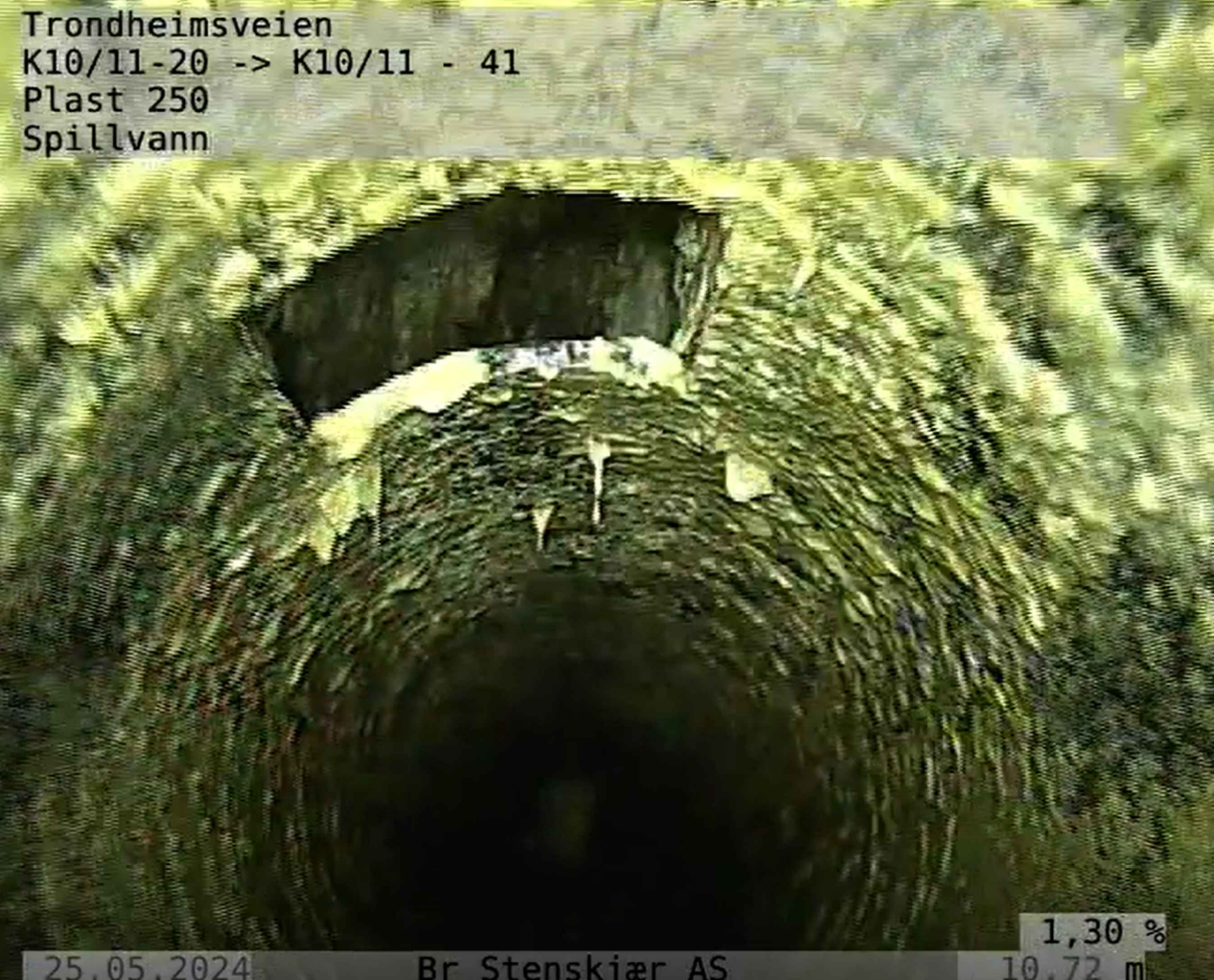
1.2 Hull på ledningen, ca 4,89m
