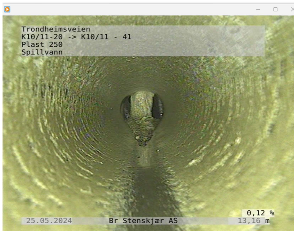
Figur 4: Bilde fra rørinspeksjon mot K10/11-41 motstrøms viser tykk biofilm i hele røret og store klumper med avleiring i innløpskummen for pumpeledningene
