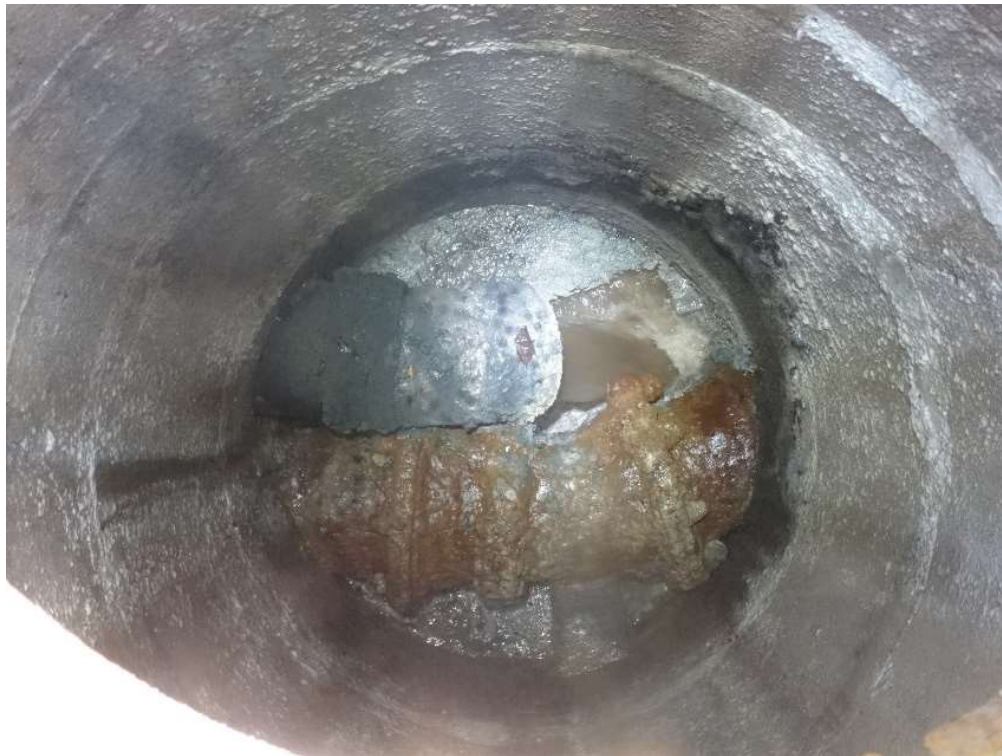
Figur 9: Kum K11/7-6. Spillvannsledning Ø200 føres inn på SP 300. Vannledning går igjennom kummen og er sterkt korrodert
