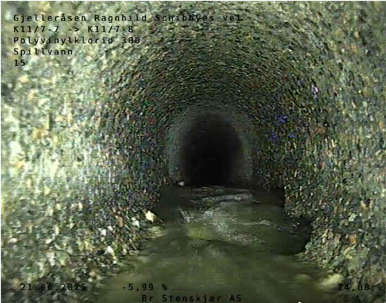
15.3 Rørbiter har løsnet eller mangler. Fra kum K11/7-7 til kum K11/7-8. Ca 70,72m
