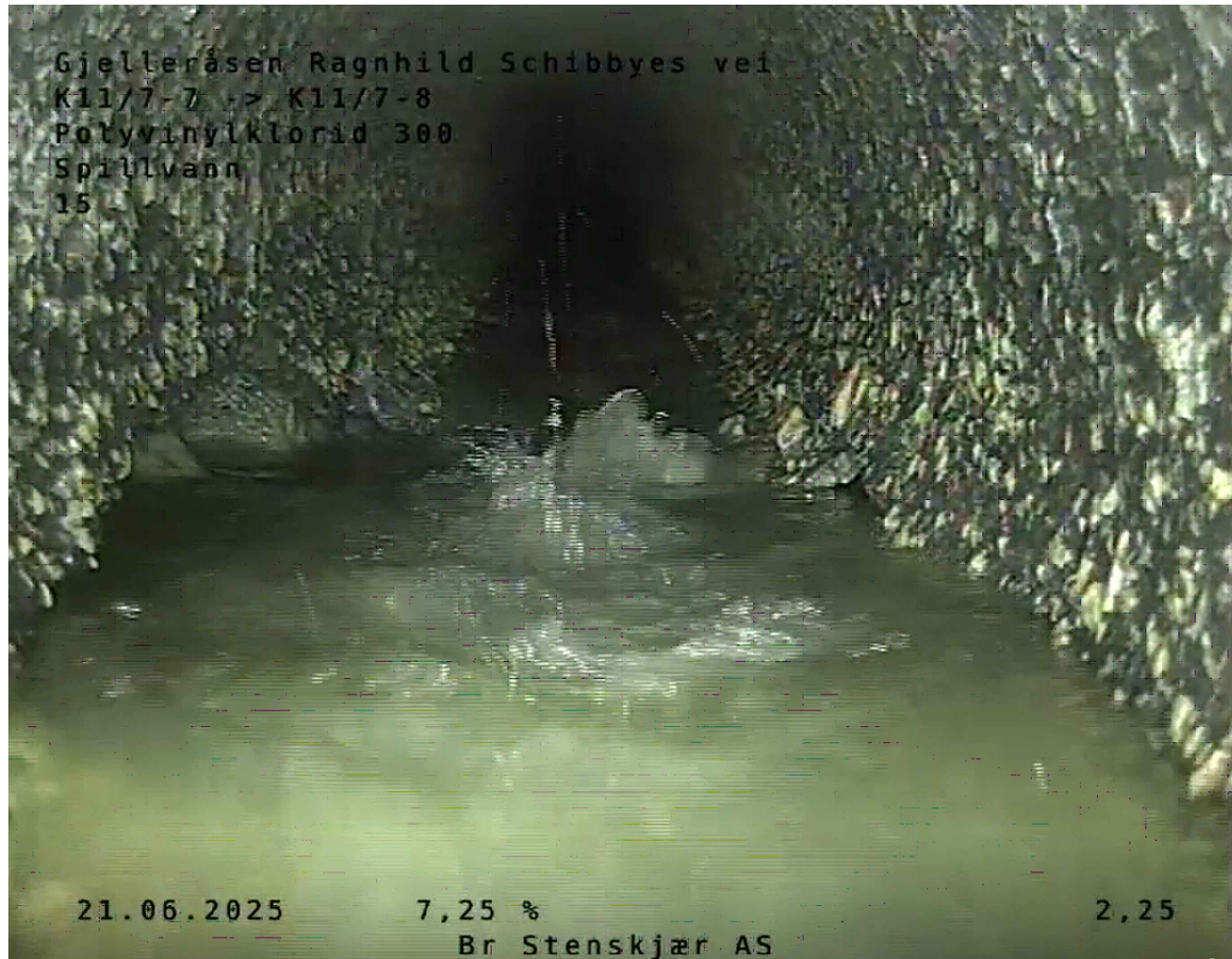
15.1 Rørbiter har løsnet eller mangler. Fra kum K11/7-7 til kum K11/7-8. Ca 48,97m
