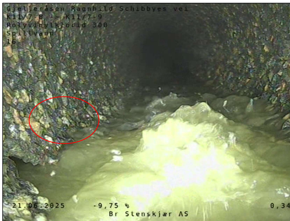
Figur 13: Skader på rørveggen 1m nedstrøms fra K11/ 7- 8
