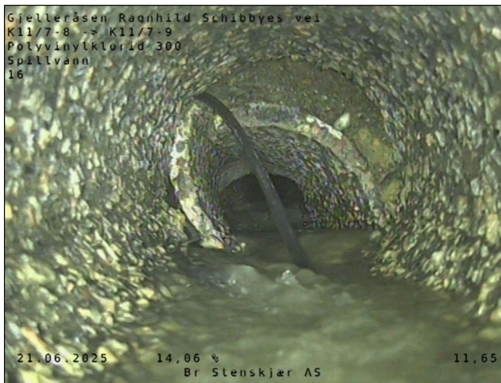
Figur 12: Kollapset betongrør mellom K11/ 7- 8 og K11/ 7- 9
